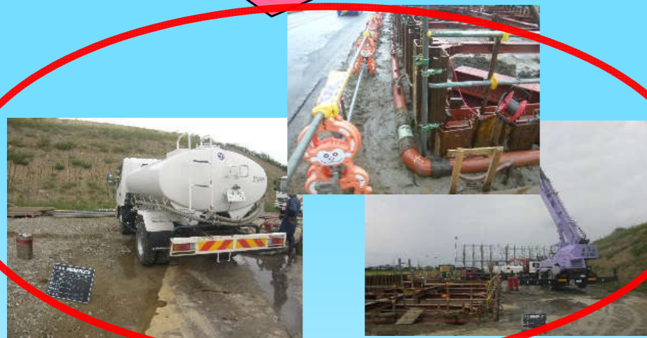
クレーン・給水車・戻り水の溝
